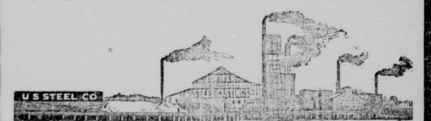
Det nuværende Anlægs Flod Front i Everett, Mass., en Forstad til Boston, hvor Kompagniet ejer 74 Acres Land, har baade Jernbanestationer og Anlægsbolværk. Paa dette Land er bygget en moderne Fabrik, 200x130 Fod, forsynet med elektriske Kraner, Smelteovne, Tørrerovne, Gasfrembringere, Kjedler, Maskiner, Dynamoer, Sandblæsere, Krumningsanlæg, „Finiishing“ Maskiner, Kontorer o. s. v.
