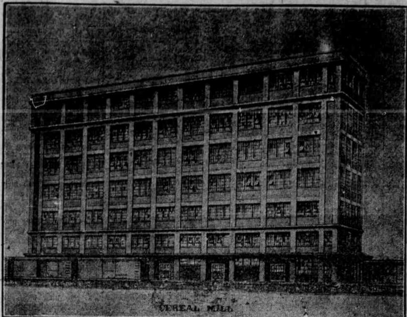
Die Cerealienmühle ist ein siebenstöckiger Bau aus Konkretegestell und -fluren, mit Fachwerk aus Backsteinen; sie ist arrangiert für die Herstellung von Corn-, Hafer- und Weizen-Produkten, ausgestattet mit den neuesten verbesserten Maschinen, gesundheitslich, strukturfest und nach dem Taglichtplan konstruiert, mit viel Sonnenlicht. Sie bedeckt einen Flächenraum von 107,832 Quadratfuß, einschließlich Ladeplattformen.
