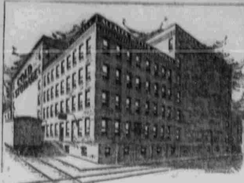
Was wir benötigen und auf bereits gekauftem Grundeigentum erbaut werden.
