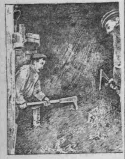
Arbeiter beim Ausbrechen der blauen Erde.
