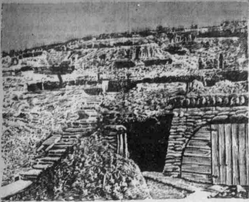
Eisenweise angelegte französische Schützengräben und Sicherungsanlagen an einem kleinen Hügel nahe bei Verdun.
