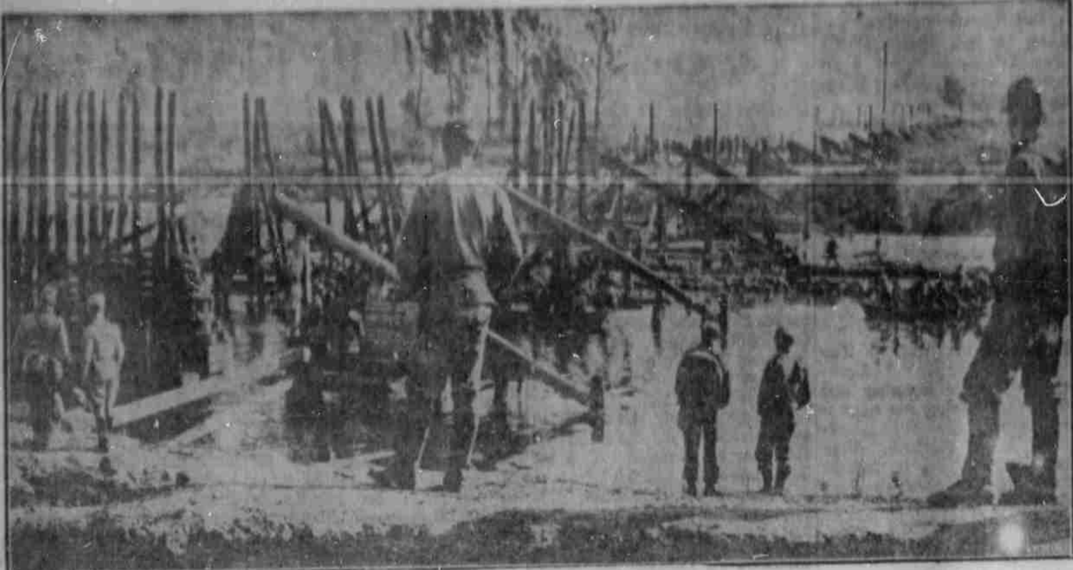
Wiederherstellung einer von den Russen auf ihrer Flucht in die Luft gesprengten Brücke über die Wislocka durch deutsche Pioniere.
