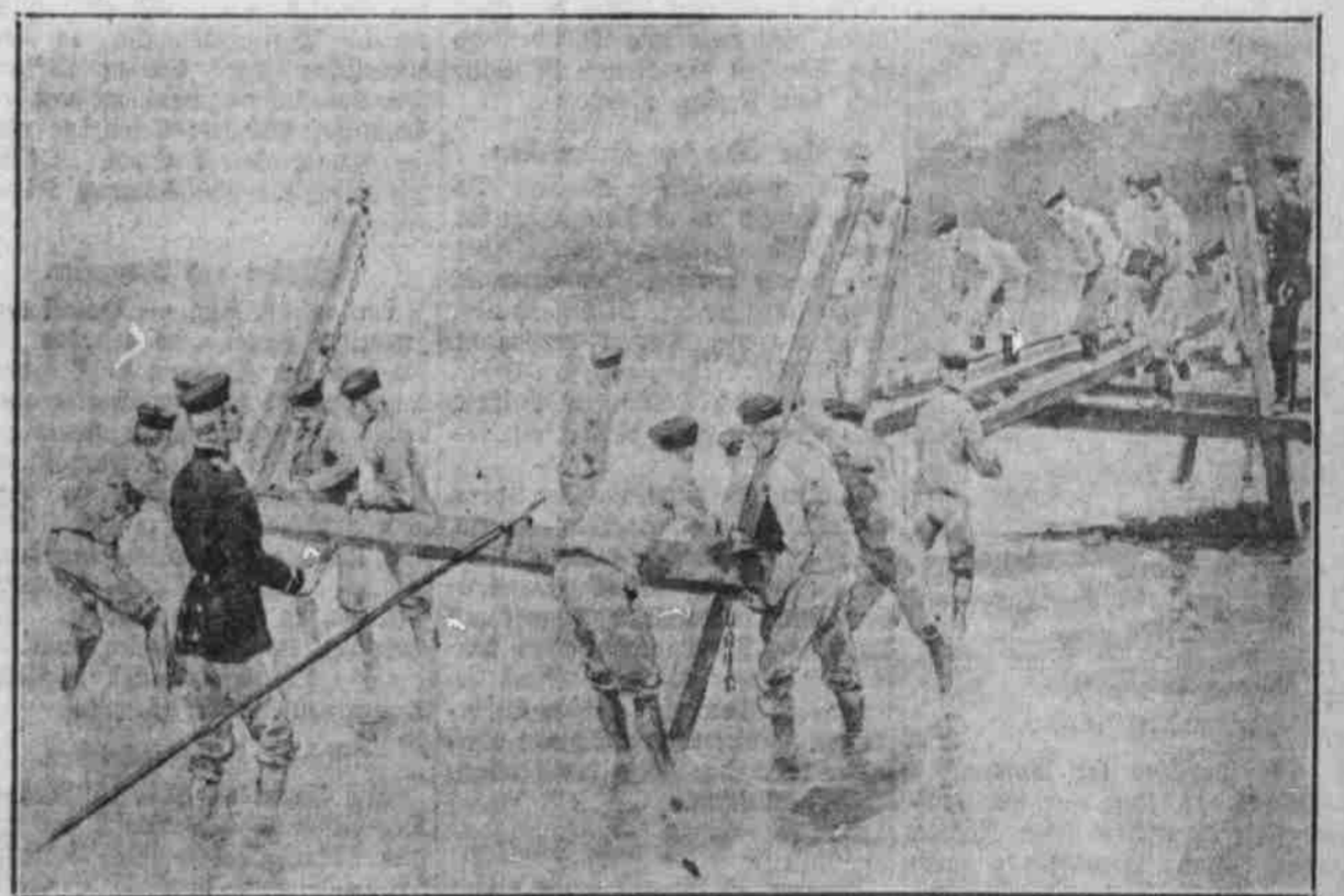
Deutsche Pioniere beim Überbrücken eines Flußes.
