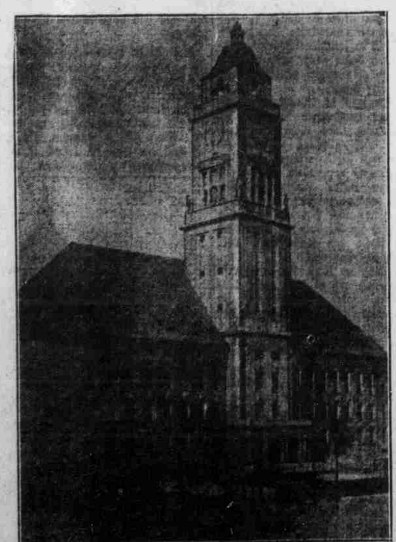
Das neue Rathaus in dem Berliner Bezirk Schöneberg zeigt mit seiner Ausgestaltung den nummernreichen Rathausplatzes und des anliegenden Stadtparts jenseitig zu den bedeutendsten händelbaulichen Neuanlagen Großberlins!
