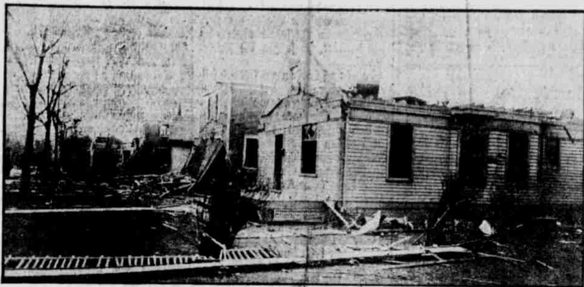
Ein Bild vom Tornado Distrikt im nördlichen Stadtteil.
