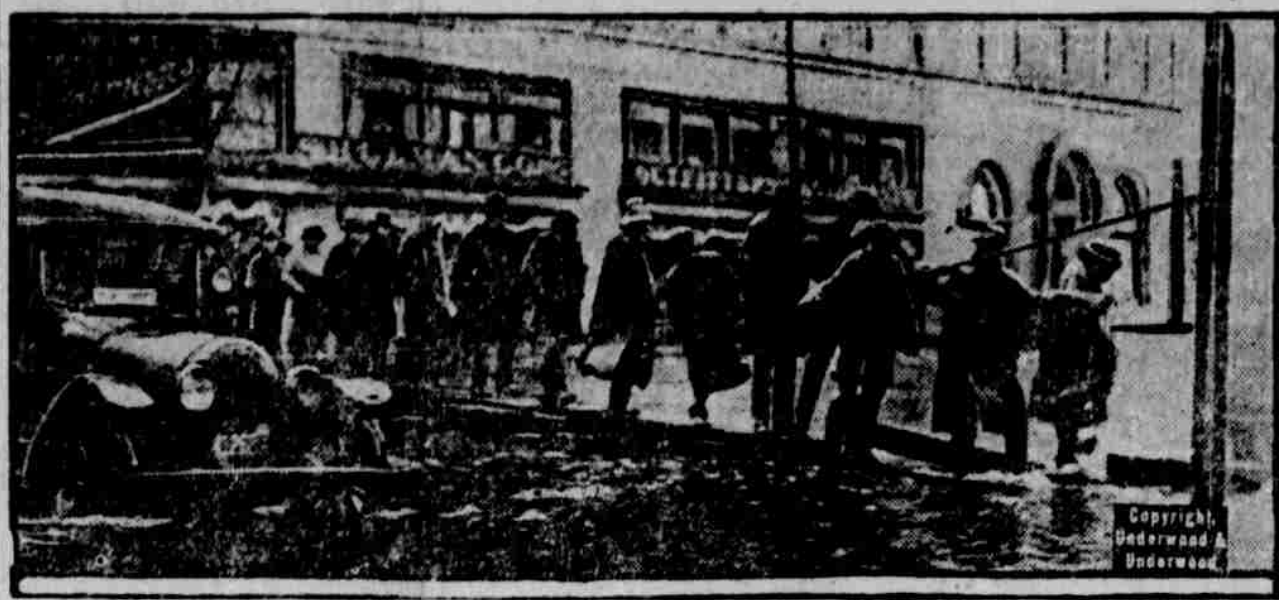
Bourě, kterou nedávno postíženo bylo celé pobřeží Atlantiku, zavinila vysoký příliv a mnoho ulic města Norfolk, Va., bylo vodami zaplaveno. Fotografie naše ukazuje vytahování automobilu ze zaplavené ulice.
