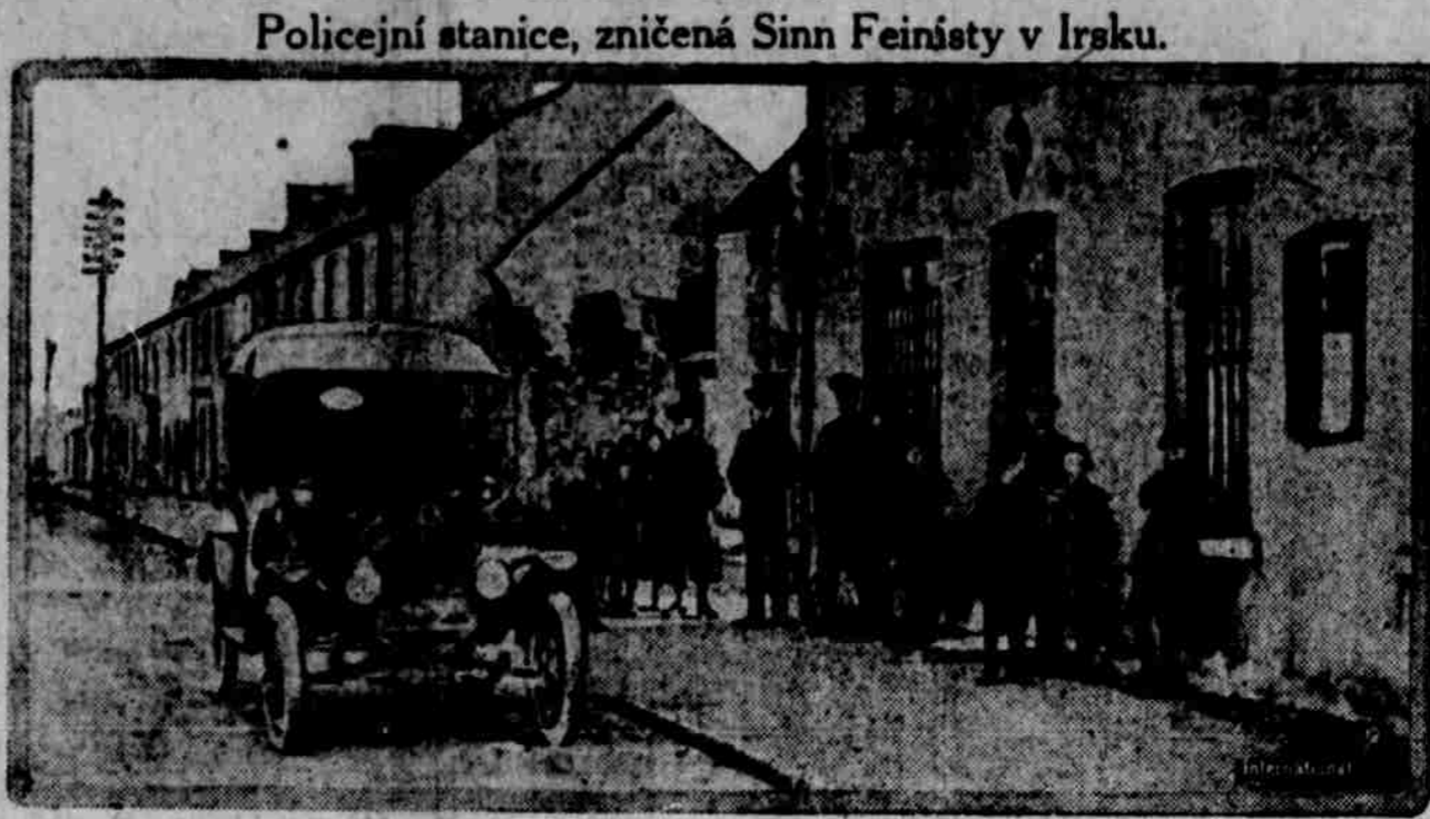
Policejní stanice, zničená Sinn Feinisty v Irsku. Stanice irských konstáblů jsou častým předmětem nájezdů Sinn Feinistů. Obrázek náš ukazuje zříceniny policejní stanice v Carrigwehill, Cork okres, která napadena byla 300 ozbrojených mužů a po zoufalém odboji obránců dobytá a zničená.
