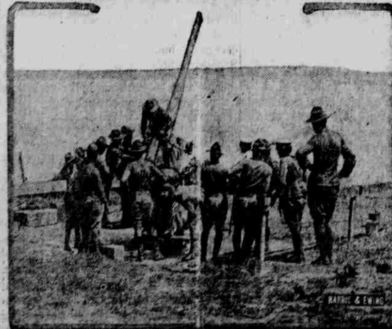
Protivzduchoplovnické dílo, kterého je užíváno jako ochrany našeho pobřežního opevnění.
