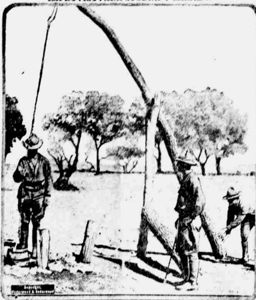
Improvisovaná studna nedaleko hlavního pobího stam spolkové armády v Mexiku. Vojáci američtí osvědčili se vynalézavými a zřídili si ve svém táboře radu studni. Voda takto získaná je lepší nežli ve studničkách a řekách.
