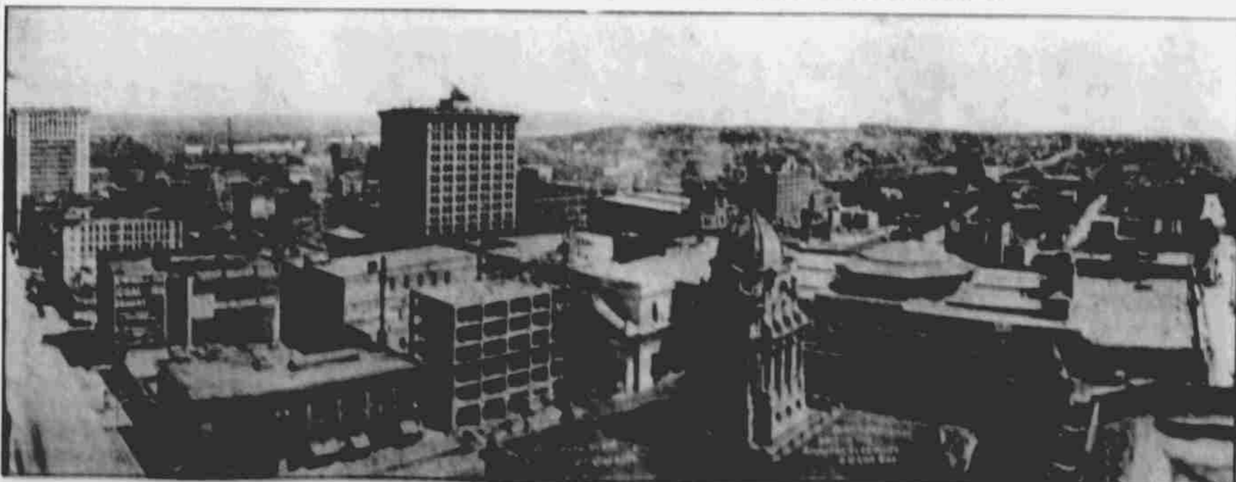
Budova Dřevatá Světových.
