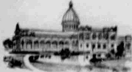
Budova státu Illinois.
