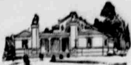
Budova státu Vermont.
