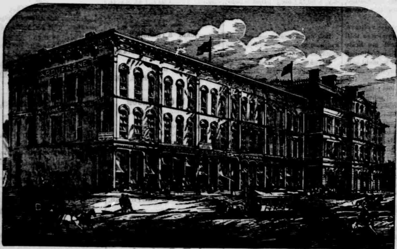
Creighton Block. Cihelná budova s železným průčelím 132 při 60 st. O třech poschodích.
