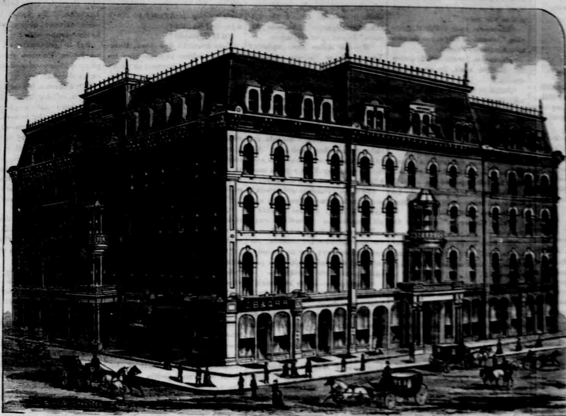
Grand Central Hotel. Elegantní budova s železným průčelím, pět poschodí vysoká. Zaujímá prostoru 132 st. do čtverce. Vystavěna s nákladem 200,000.
