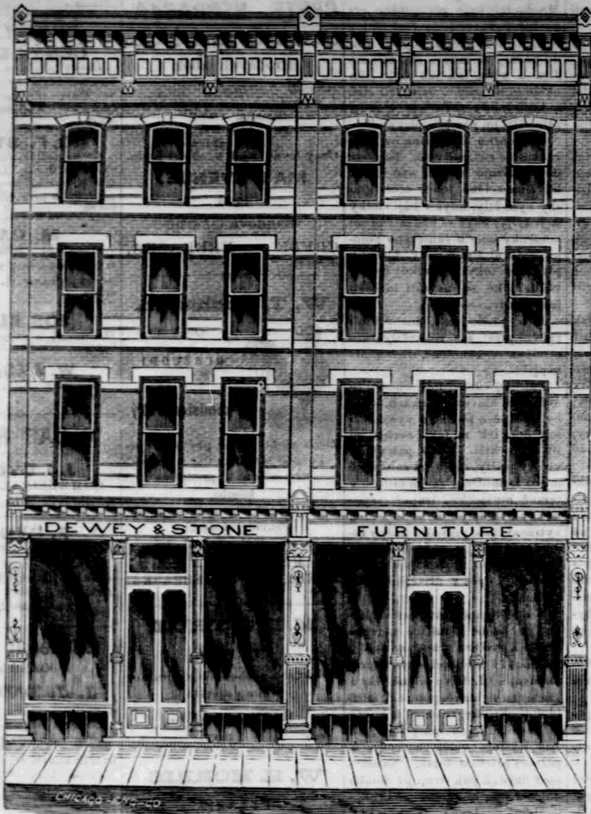
Budova pánů Dewey & Stone. Čtyřpatrová cihelná budova se železným průčelím.
