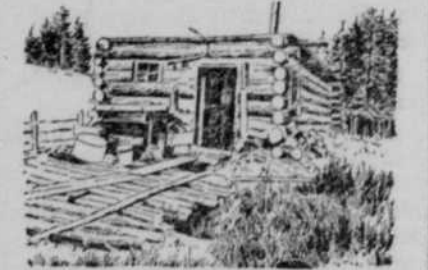
Stibo-Gebäude (erste Bergbauerhütte in Nordwest-Minnesota).
