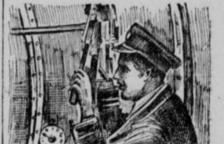
Während der Beobachtung bedient der Offizier den Hebel, um dem Auge des U-Bootes eine verschiedene Stellung zu geben. Dicht dabei sind alle die Griffe, die die Leitung des Bootes und seiner Maschinen formen, die Verbindung mit der Mannschaft gestatten.
