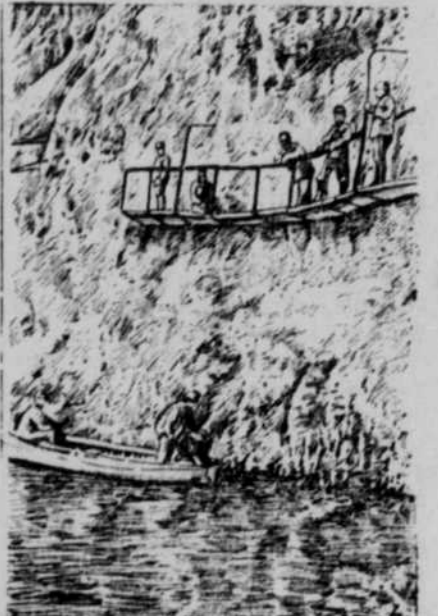
Au der Eroter Dampftramway; Arbeiter an Felsabhängen.
