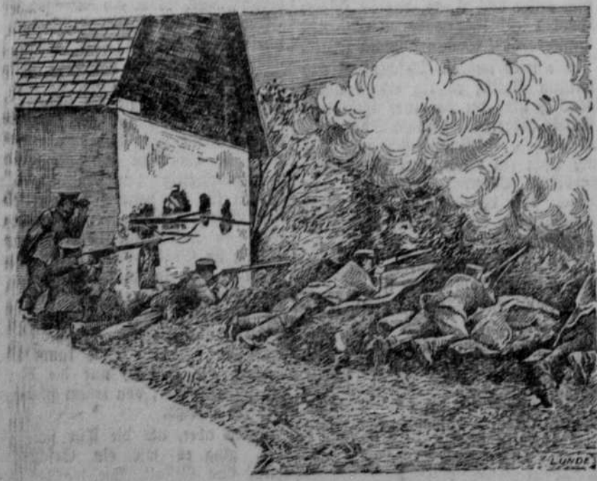
Leidigen eines galizischen Bauernhauses. In dem d. Schief-harten ausgebrochen. Der Platz vor ort von einer einschlagenden Granate her.
