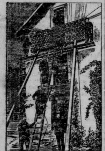
Die von einer deutschen Fernsprechabteilung gebaute Einföhrung zur Telephonzentrale.
