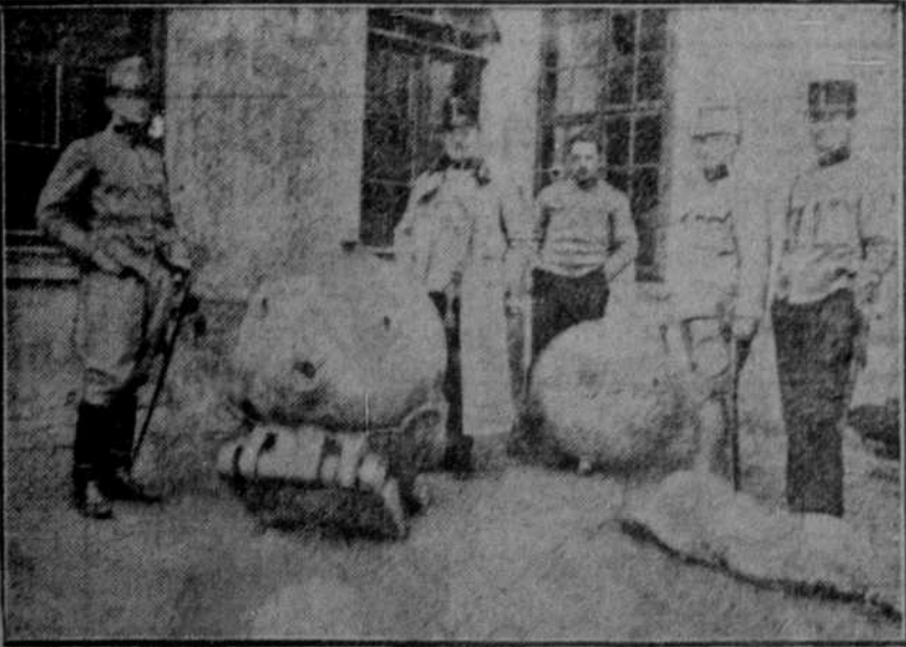
Serbische Flusskrieger, die von den Oesterreichern aus der Save geißelt wurden. — Der untere Teil ist die Verankerung, die die schwimmende, mit Explosivstoffen gefüllte Kugel festhält.
