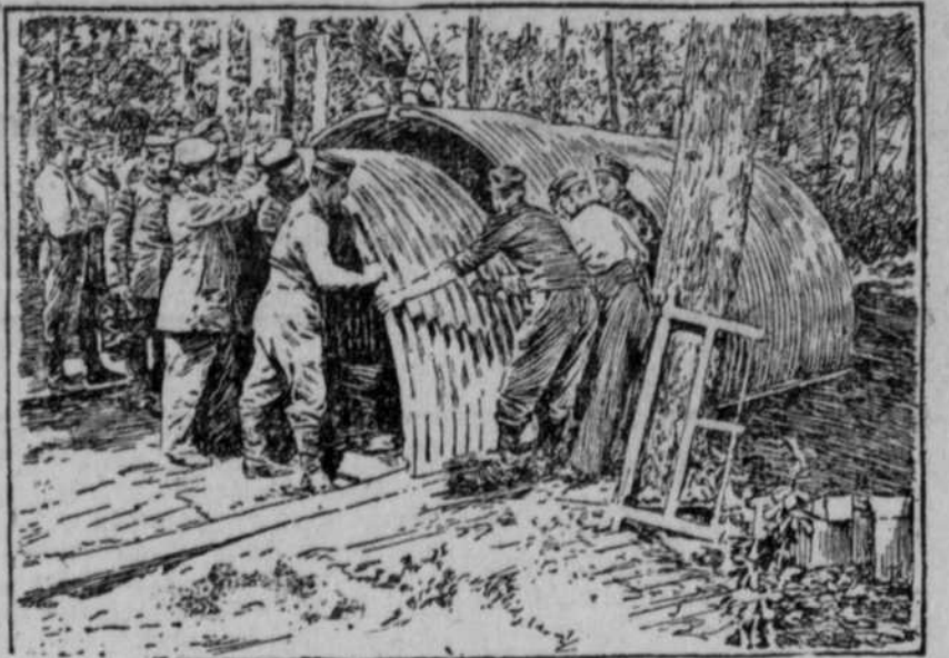
Deutsche Soldaten beim Bau von Unterständen aus Wellblech auf dem westlichen Kriegsschauplatz.
