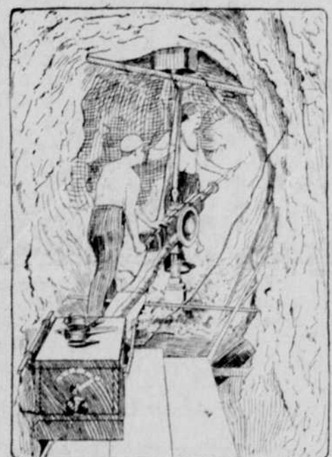
Electriche Bohrmaschine beim Gesteinsbohren.
