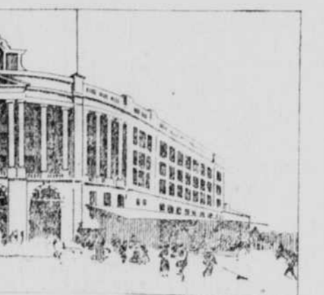
Der neue Bahnhof in Boston. Frontansicht Süd der Summer- und Federal-Street.
