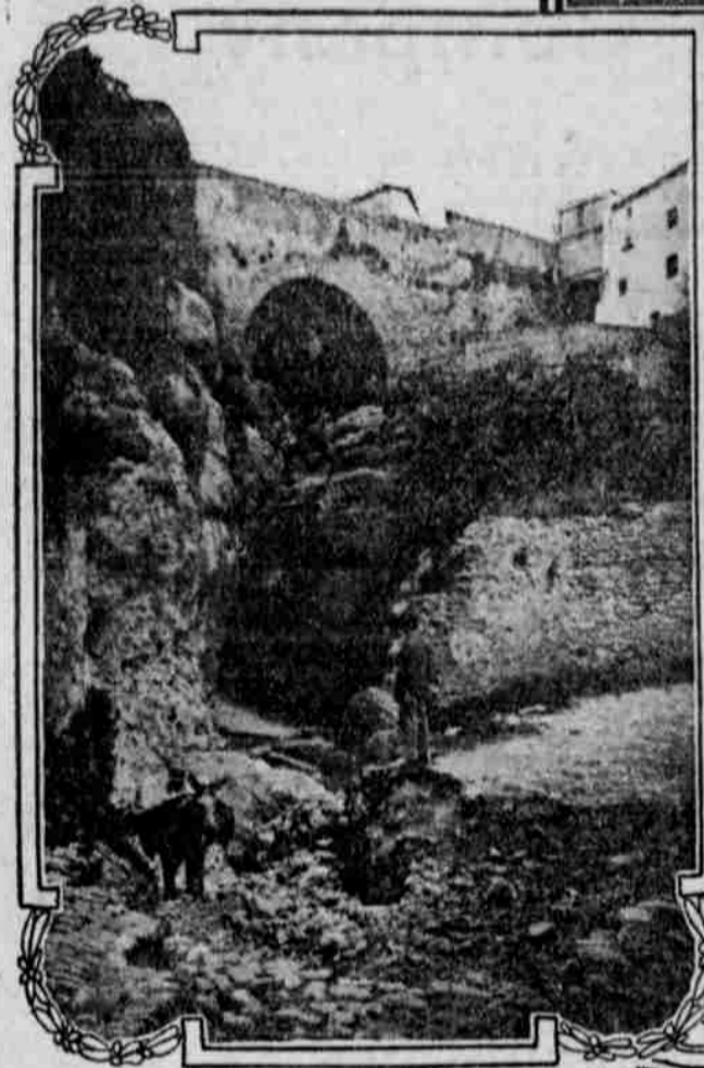
PUENTE DE SAN MIGUEL, RONDA
