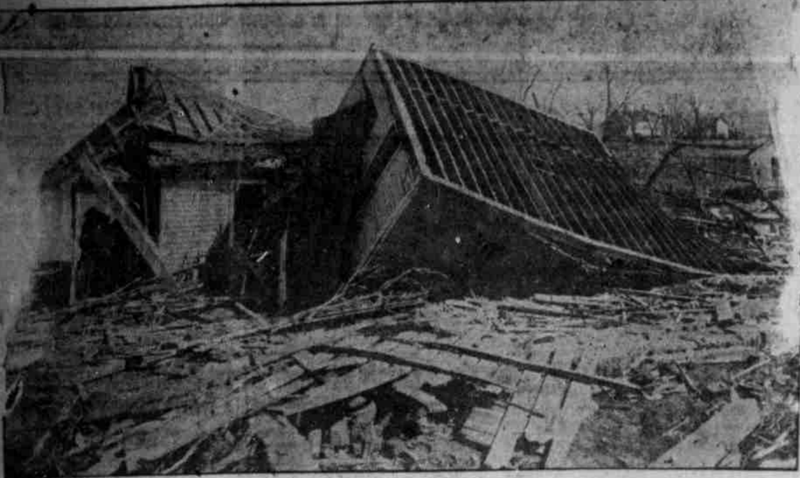
Das Heim von Roy Gibson, 631 S. 50. Ave., wurde gegen das Heim des Albert Hall, 629 S. 50. Avenue, geschleudert.
