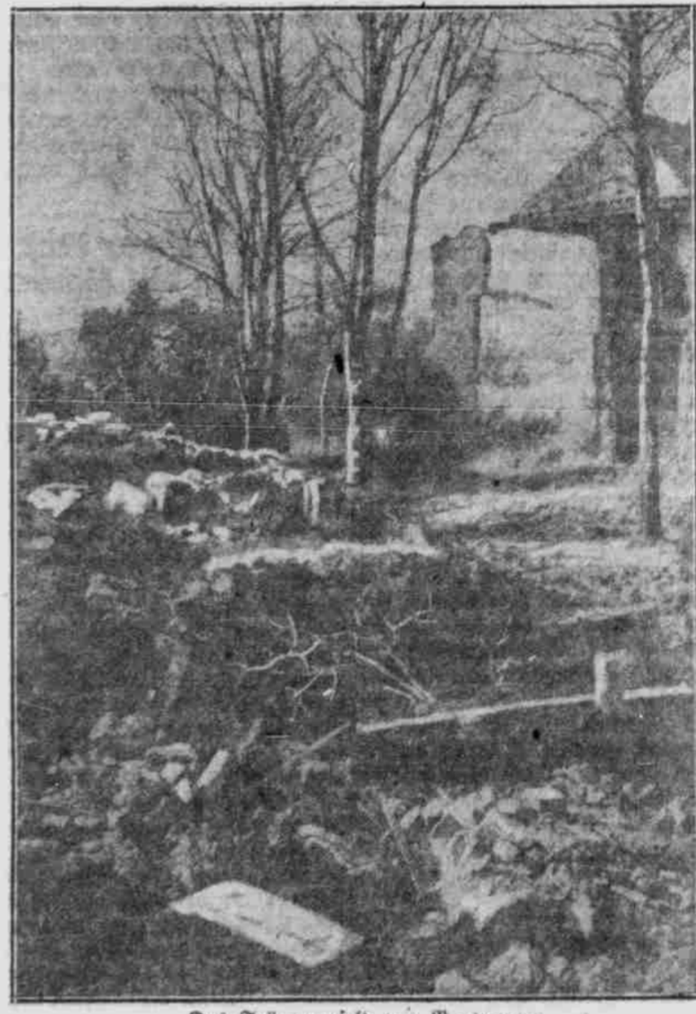
Das Trümmerfeld von Baupenne.
