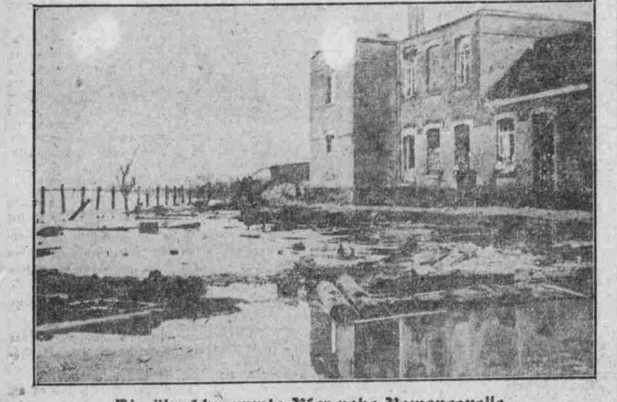
Die überschwemmte Ufer nahe Ramoncapelle.
