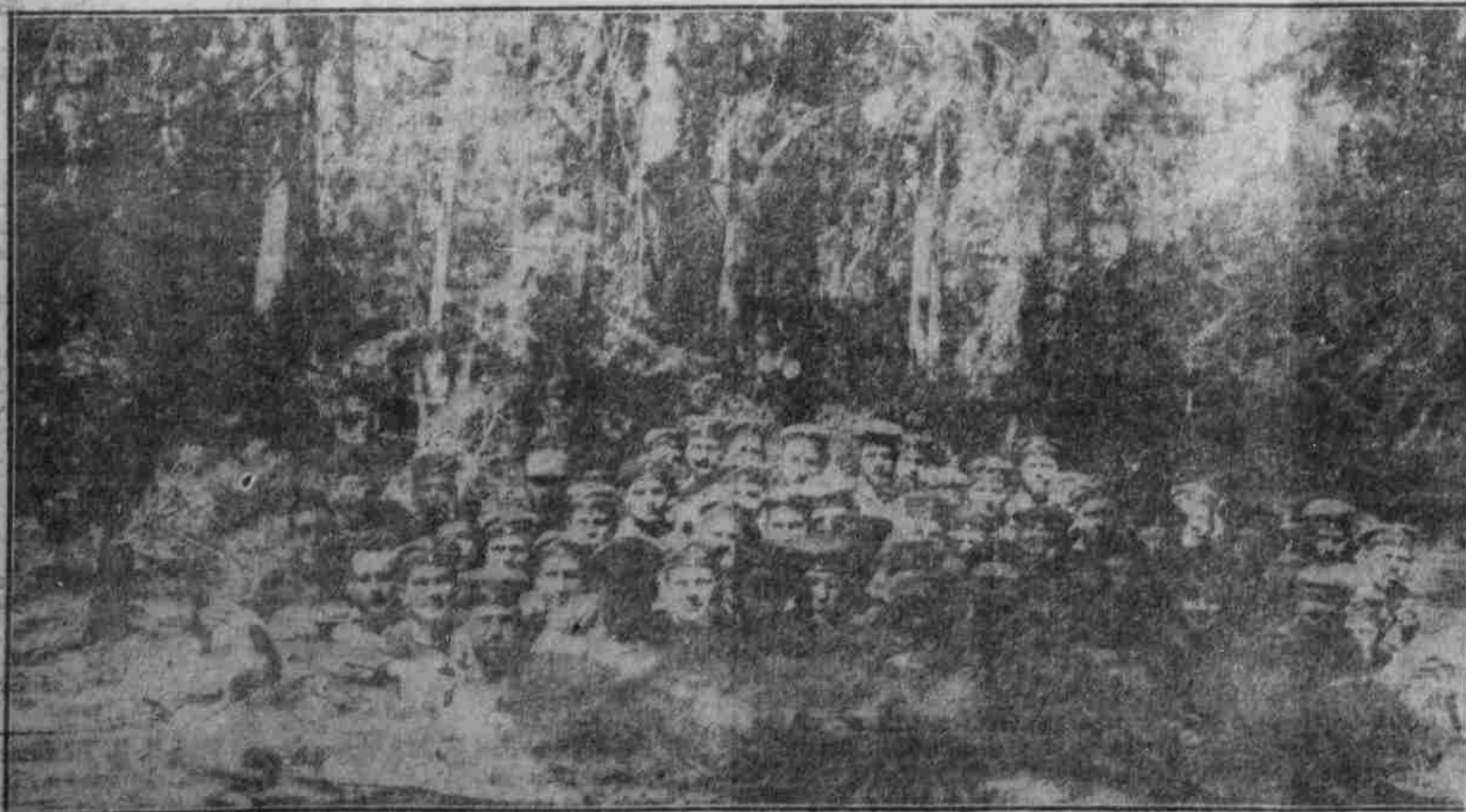
Eine bemerkenswerte Granatschutzwirkung: Von einer Granate gerissenes Loch, in dem 50 Soldaten Platz haben.
