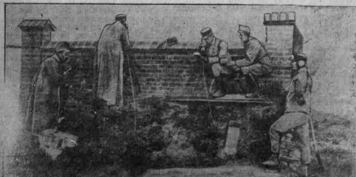
Oesterreichisch-ungarische Batterie-Telephonstellung im Feuer in einem galizischen Tofse.
