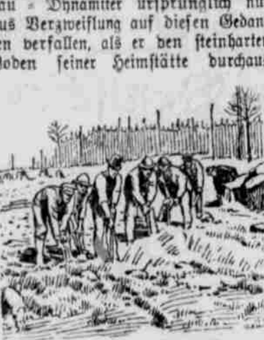
Das Bohren von Sprenglöchern.
