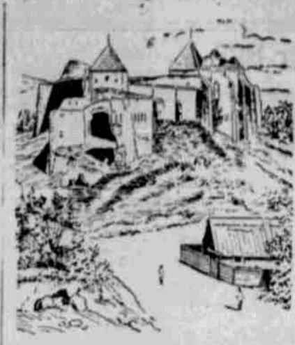
Die Bauernburg Stolzenburg bei Hermannstadt, ein nicht ausgebautes Kirchenanwesen.
