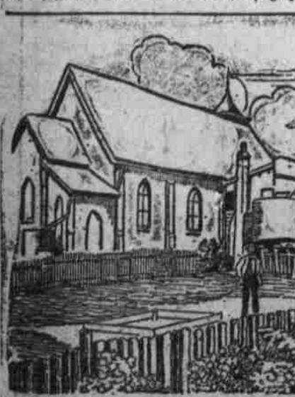
Warenhaus und Kirche in einer deutschen Siedlung.
