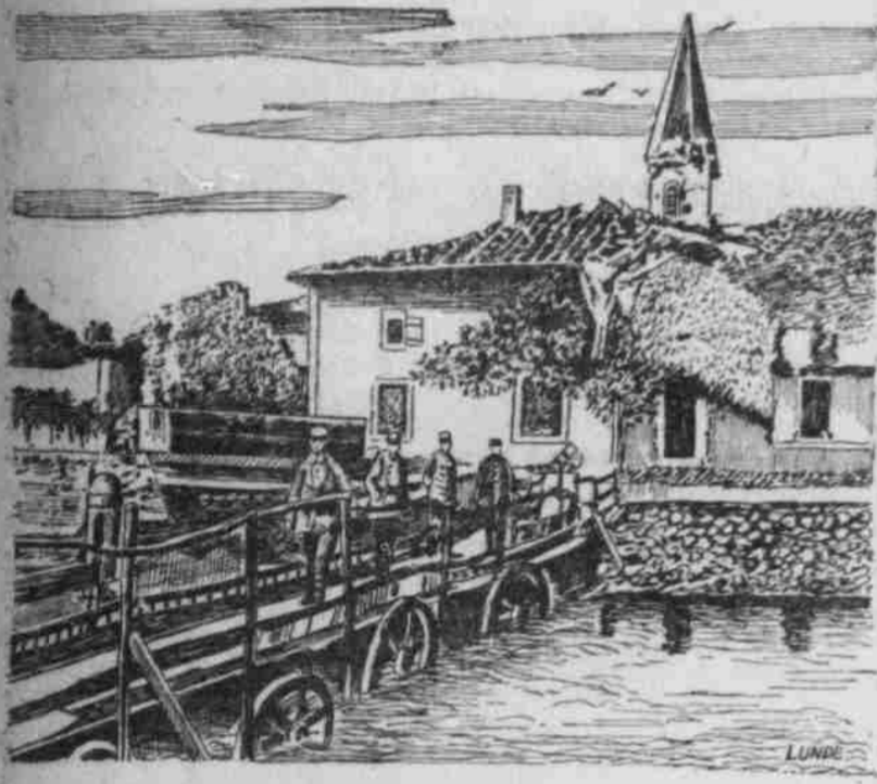
An der Naas. Aus Wagen konstruierte Brücke.
