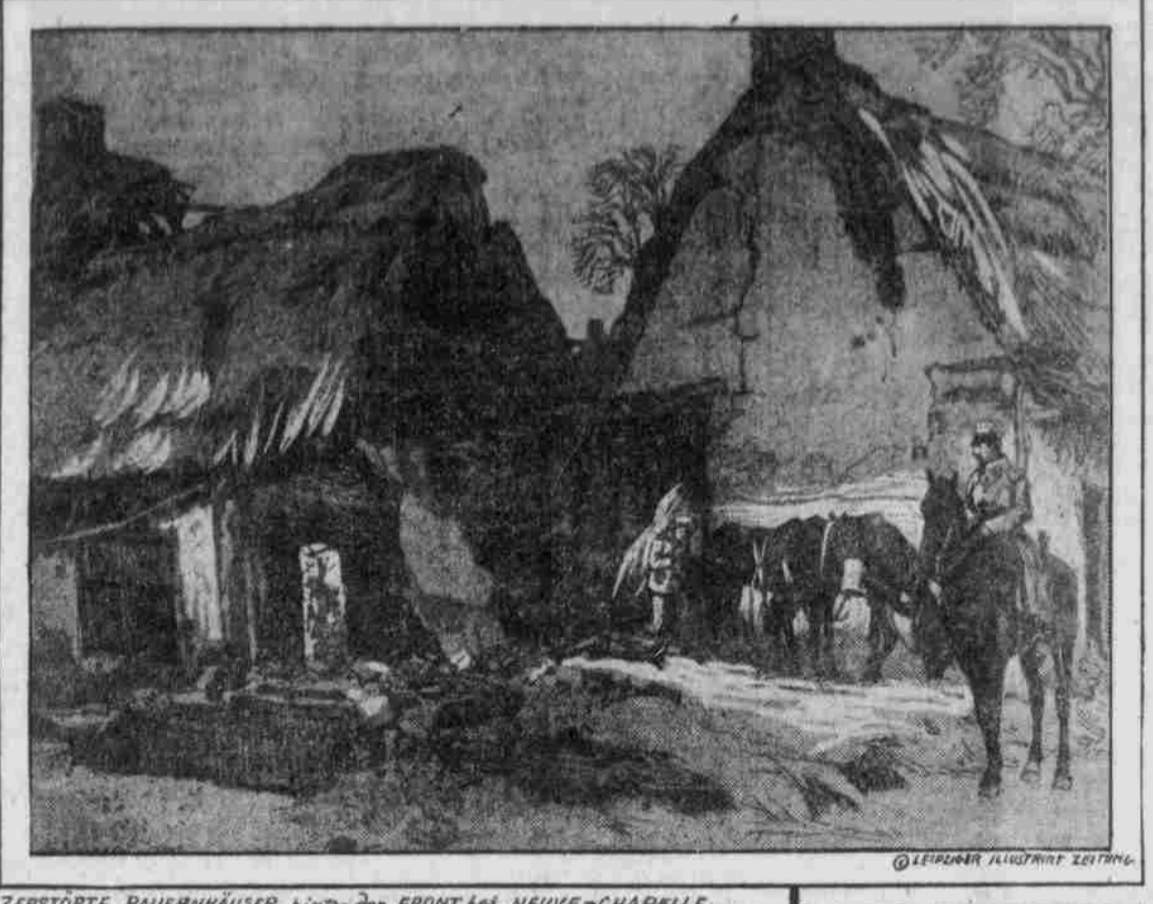
ZERSTÖRTE BAUERNHÄUSER hinter der FRONT bei NEUVILLE-CHAPELLE.
