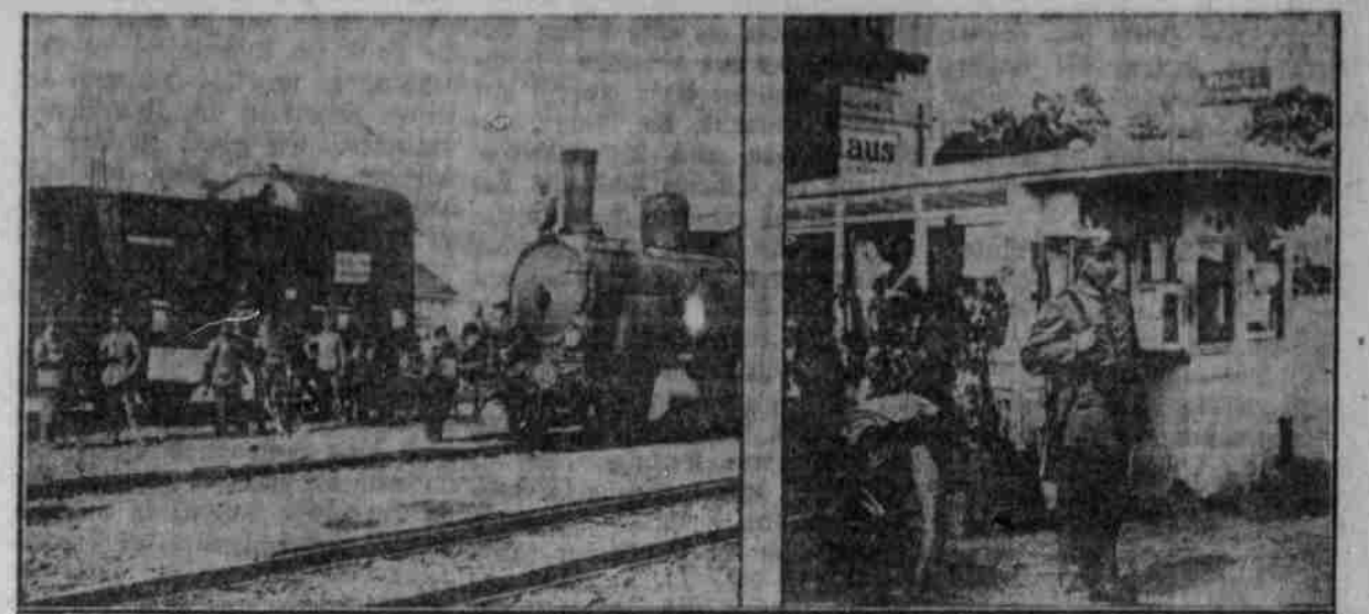
Eine eigenartige Eisenbahnstation auf dem weithin zerstörten Kriegsschauplatz. (In Ermangelung von Baumaterial wurde das Bureau des Bahnbetriebers in einem alten belgischen Eisenbahnwagen aufgeschlagen, woselbst auch die Fahrkartenausgabe stattfindet.)
