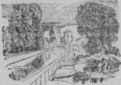
Kanalbrücke über die Marne bei Langres.
