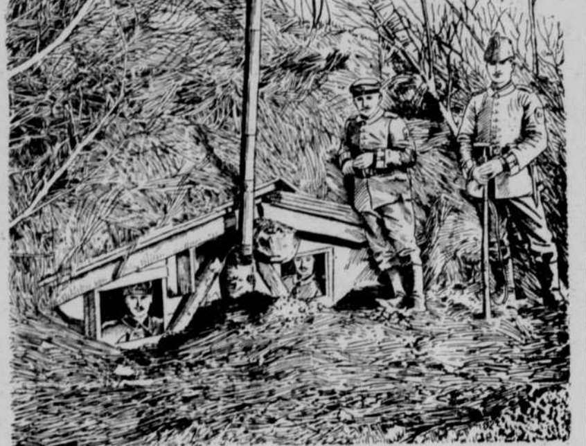
Eine „Villa“ unter der Erde; Unterschlupf eines Fliegerpostens vor Reims.
