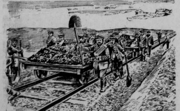
Wann eine Feldbahn durch deutsche Eisenbahntuppen in Frankreich. Auf Vorder wird der Schotter nach dem vorbereiteten Unterbau gebracht, während Waggons und Schienen nachfolgen, so daß der Bau mit fahrbahner Gewandtheit und Schnelligkeit vor sich geht.
