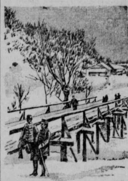
Eine Rotbrücke in der Bukovina.
