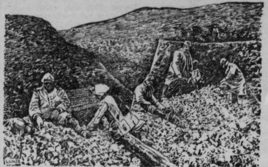
Im Westen. Deutsche Soldaten klopfen Steine, die zur Ausbesserung der Straßen gebraucht werden.
