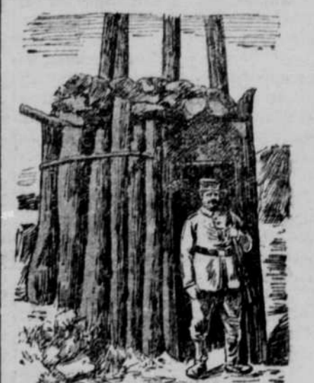
Das Dach des ursprünglichen Schilderhauses ist mit Erde, auf der das Gras wächst, bedeckt.
