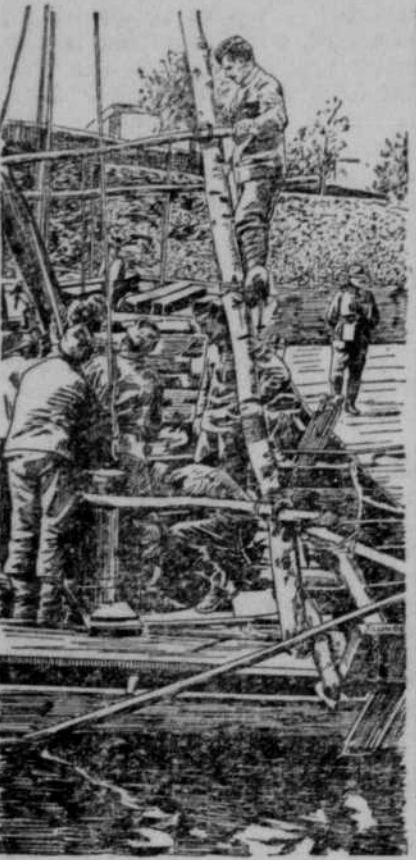
Oesterreichisch-italienische Pioniere bauen eine Brücke über den Bug.
