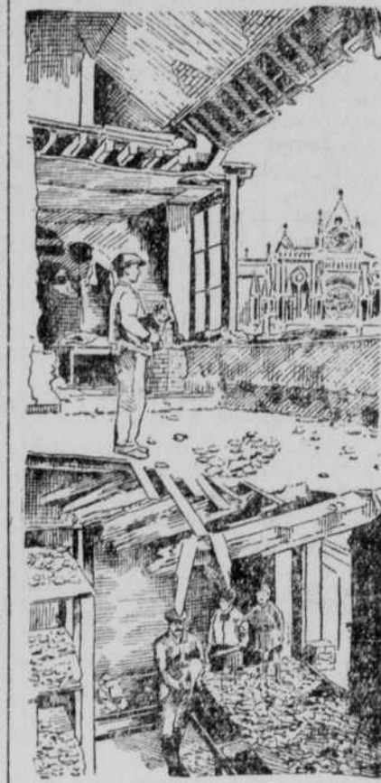
Zweites und drittes Stadtwert eines von einer 21-Zentimeter - Granate getroffenen Hauses in Kairo.
