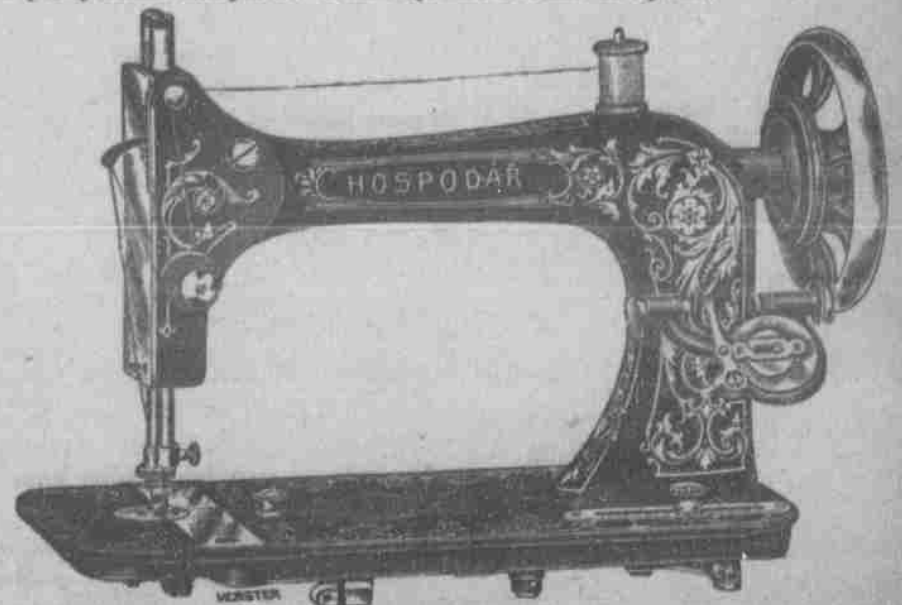
Hlavice stroje Hospodář, na které zobrazena jsou částečně nová zdokonalení.
