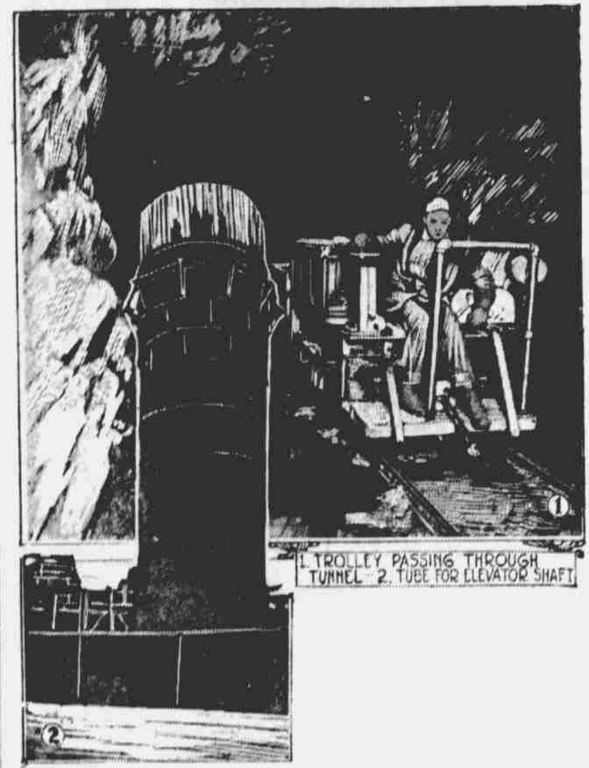
Nový vodovod z pohoří Catskill, na jehož zbudování bylo vynaloženo $152,000,000, vniká do města New Yorku ve hloubce více než 400 stop, při 149. ulici a St. Nicholas Place. Obrázek tento znázorňuje elektrickou dráhu procházející tunelem a šachtu pro elevátor.
